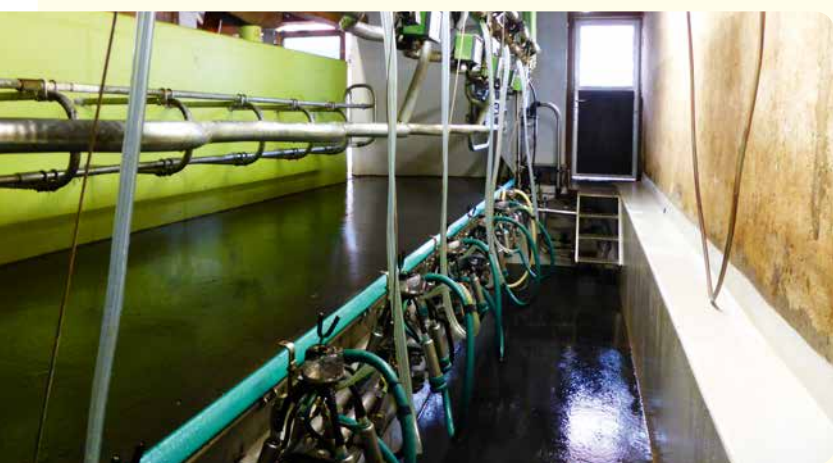
Ins Altgebäude integrierter einreihiger Fischgräten-Melkstand
